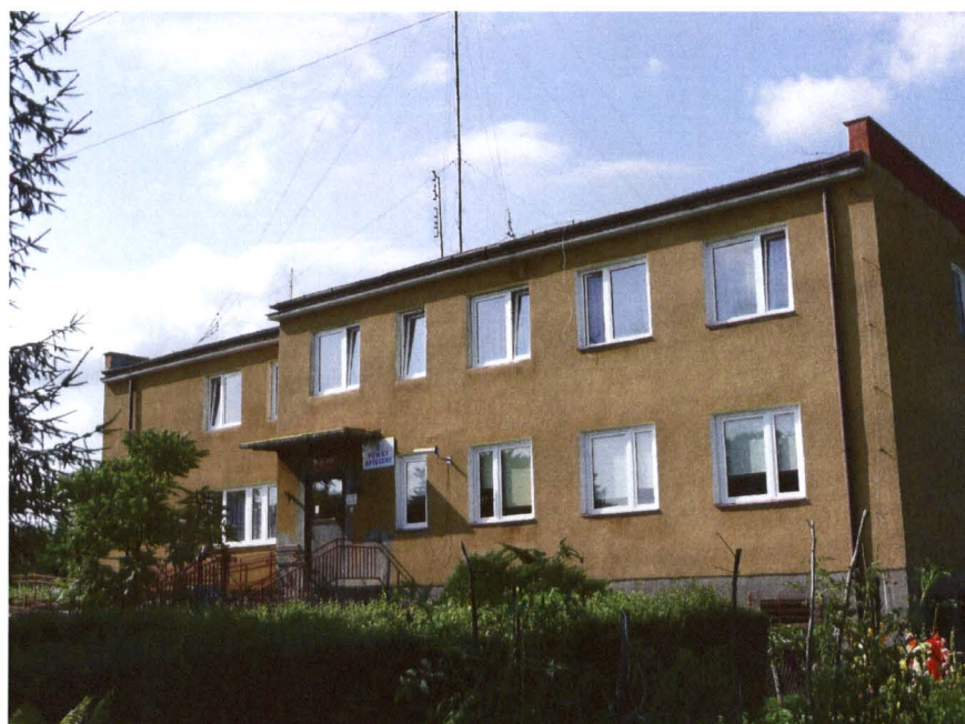
Ośrodek Zdrowia w Brzostkowie ELEWACJA POŁUDNIOWA Fot. K. Tometczak
